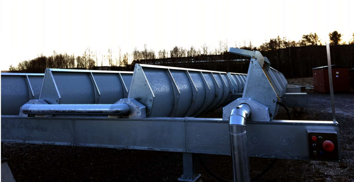
Nyinstallerade Absolicons T160 på Energiparken i Härnösand en tidig decembermorgon.
